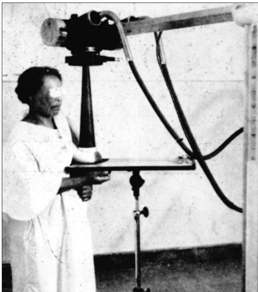
Figur 2. Raul Leborgnes mamмографiustruening [4]. Notera den långa konen med vilken bröstet komprimeras via en liten kudde mellan bröst och kon. Filmen ligger i ett svart kuvert i direkt kontakt med bröstets undersida.
