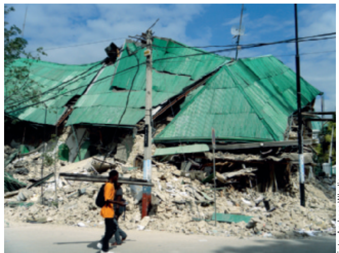
Byggnaden som inrymde hälsoministeriet i Port-au-Prince raserades vid jordbävningen i Haiti i januari 2010.
