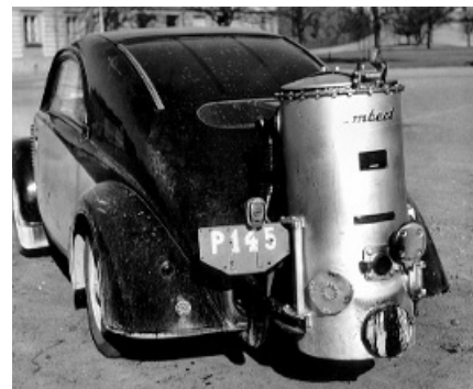
Bil med gengasaggregat, maj 1941. Aggregaten matades med vedflis eller träkol som fick brinna under strypt lufttillförsel. Slaggnings- och sotning av aggregaten måste göras kontinuerligt och utefter vägarna fanns särskilda »slaggningsplatser« upprättade.
